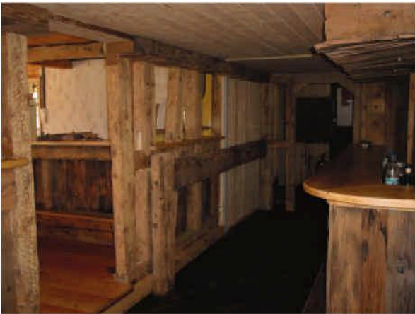
Umbau Q-Bar, CH-8808 Pfäffikon/SZ. Ein Umbau vom Restaurant zur Party-Alm.
