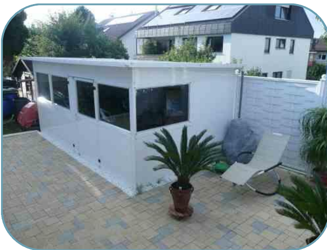
Werkstatt und Geräteraum lärmgedämmt
