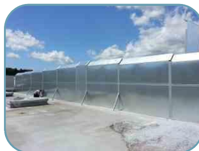
Lärmschutzwände im Jetdachbereich zum Schutz vor Lärmaustritt
