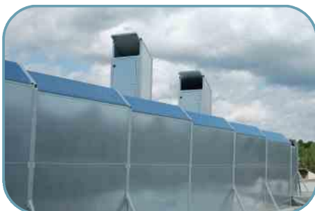
Lärmschutzwände im Jetdachbereich zum Schutz vor Lärmaustritt
