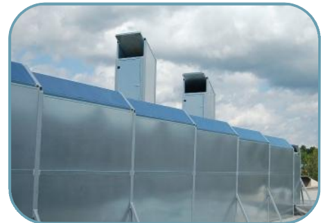
Lärmschutzumhausung im Freien mit Anpassung an ansteigendes Dach
