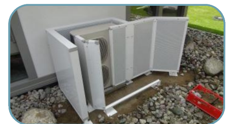
Lärmschutz für Klimageräte und Wärmepumpen mit Luftleitsystem
